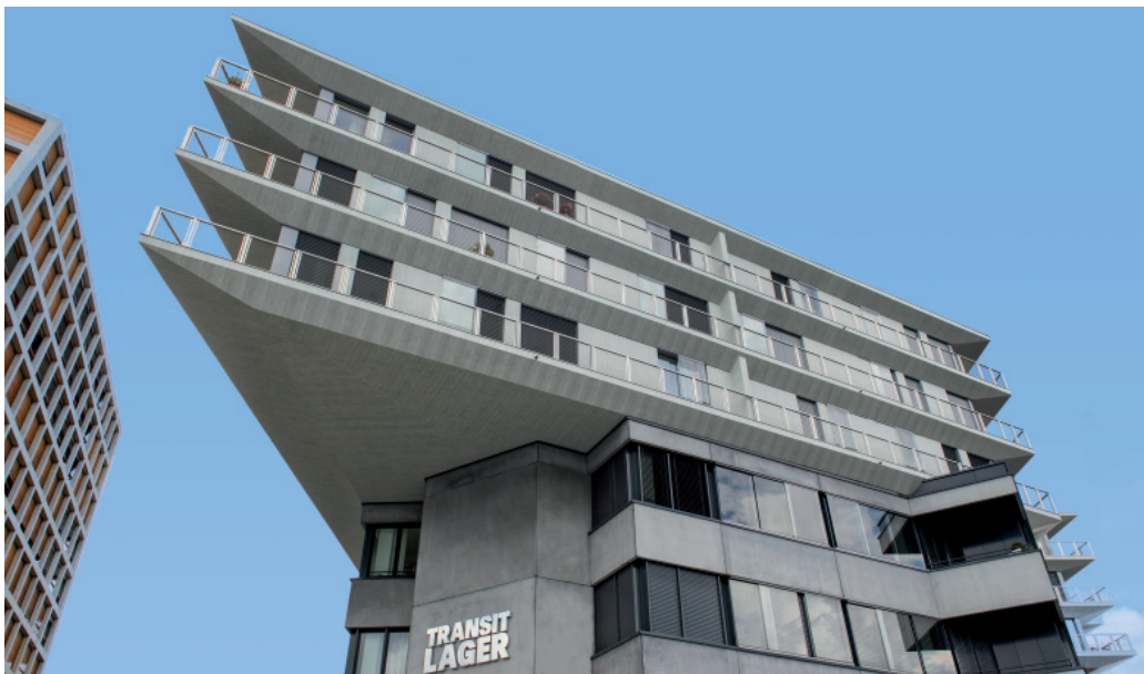
Für die Fassade des Transitlagers in Münchenstein wurden «GFK Fiberline»-Paneele verwendet.
